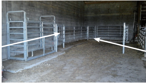
▲ Couloir en U, bétonné, de 80 cm de large.
